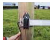
Connexion entre 2 hauteurs de conducteurs par des câbles
