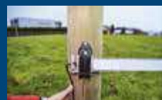
Connexion entre 2 hauteurs de conducteurs par des câbles
